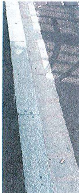
A l'intérieur du site CartoRhin, les bandes structurantes et les caniveaux formant fil d'eau seront réalisés en pavés granit.
